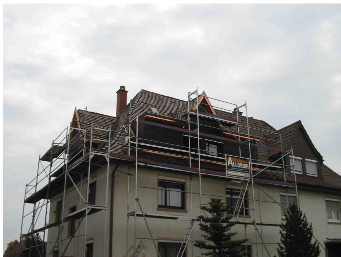
Blecharbeiten in Kupfer
