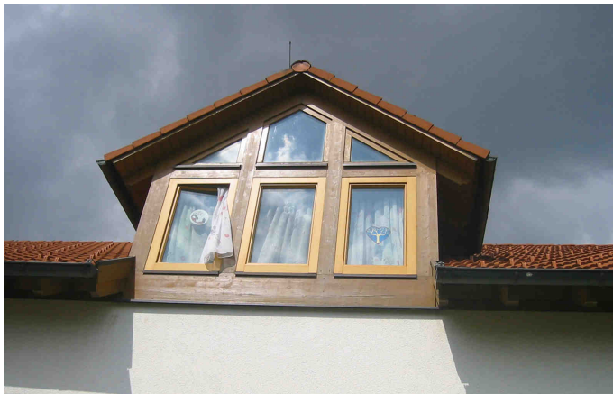
Blecharbeiten in Kupfer
