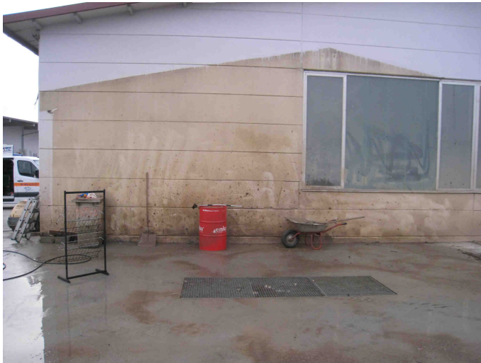
Fassadenverkleidung mit Wellblech
