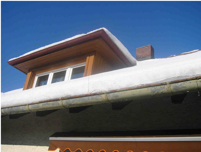
Gaupen und Kamine aus Kupferblech gefertigt.
