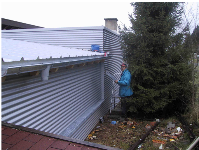
Verkleidung der Fassade mit Wellblech
